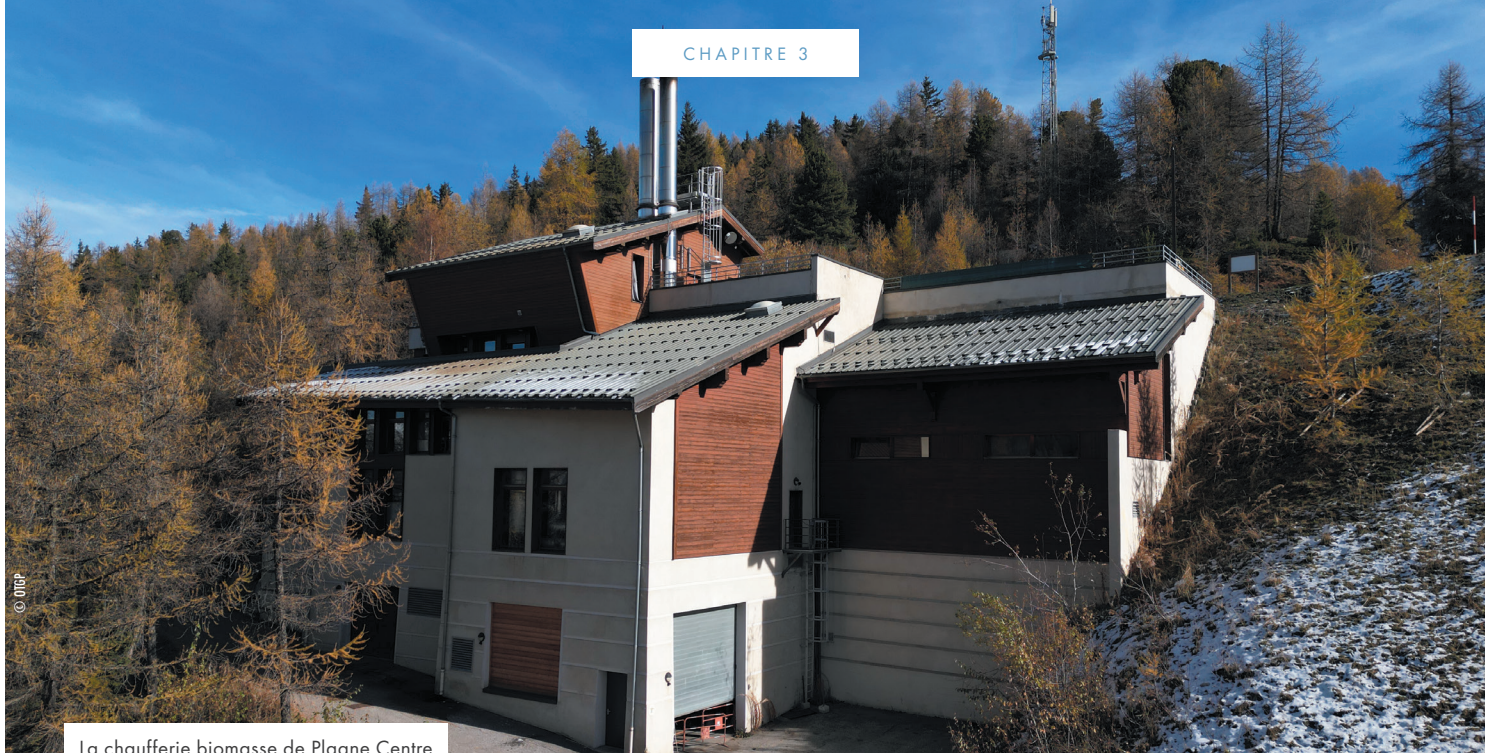
La chaufferie biomasse de Plagne Centre
